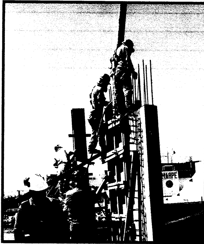
Concreto en columnas: Desinfección
