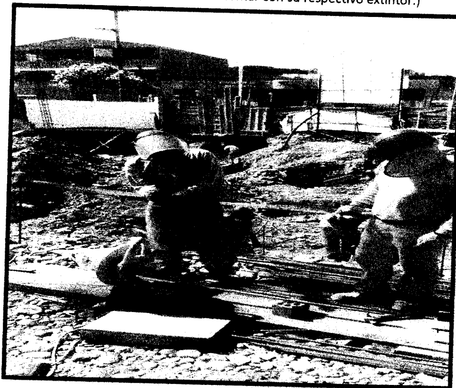
Imagen N° 07. El personal de obra que realiza trabajos en caliente no cuenta con los EPPS correspondientes (falta escarpines de cuero, guantes de cuero manga larga, y el área debe contar con su respectivo extintor.)
