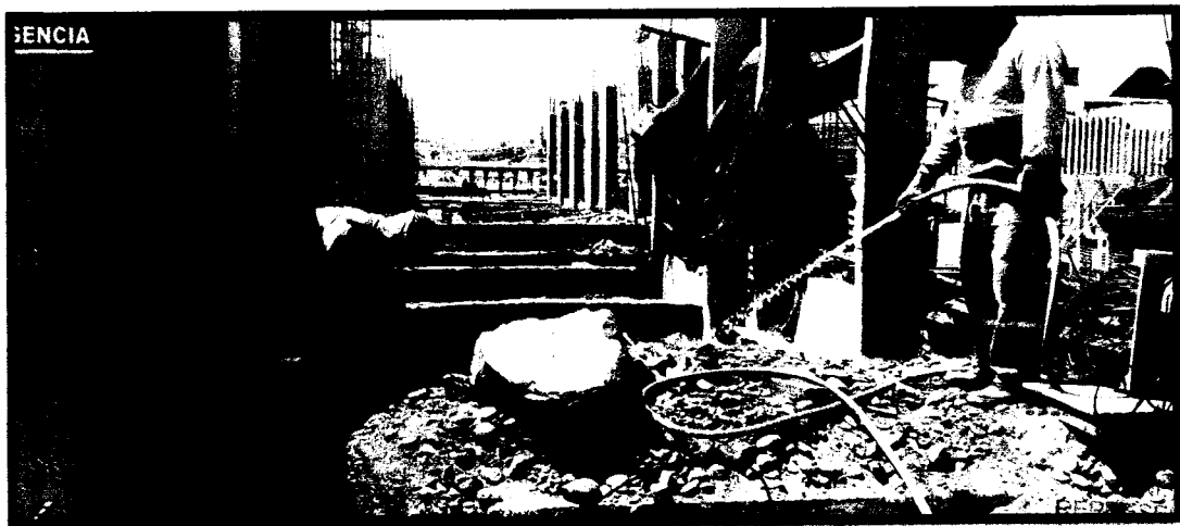
Imagen N° 33. Operario realizando riegos permanentes en diferentes puntos de obra para evitar la generación del polvo.
