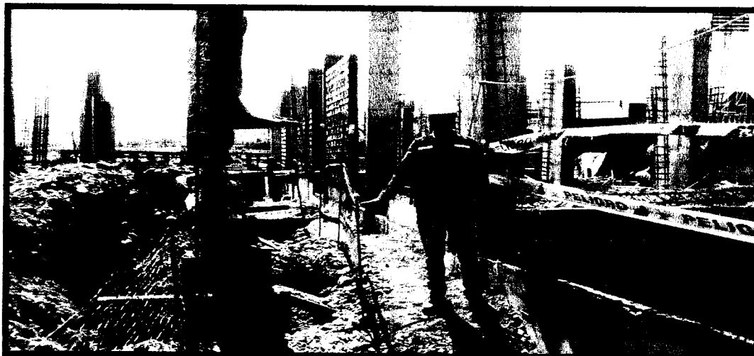
Imagen N° 12. Delimitación con cintas perimétricas y colocación de capuchones de seguridad en la zona de desinfección.
