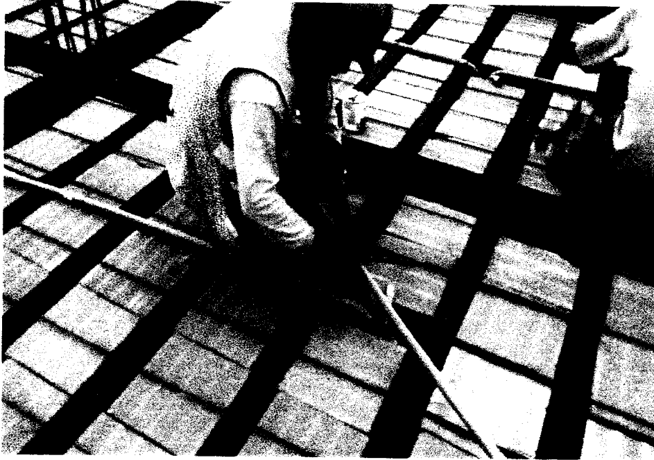
Figura 01: Se Observa al operario realizando trabajos de Instalación de Tuberías para salidas eléctricas en techo de ambiente.
