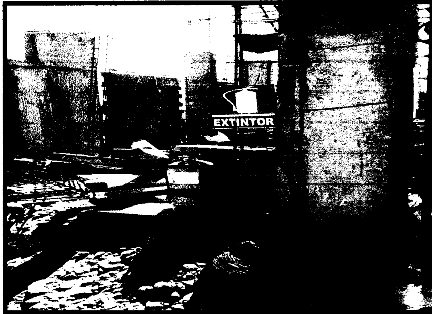
Imagen N° 36. Extintor en obra.
